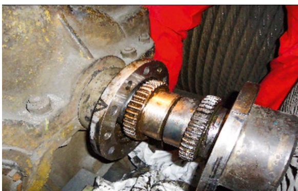
Zużycie sprzęgła zębatego – ubytek 30% pierwotnej
