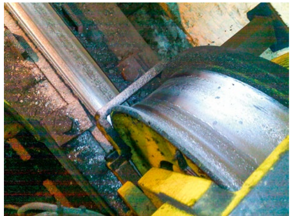
Degradacja lewego obrzeża koła jazdy suwnicy
