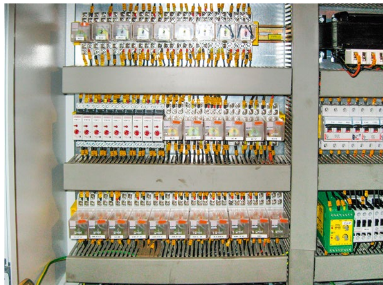
Topografia stycznikowo – przekaźnikowa wnętrza klasycznych szaf sterowniczych
